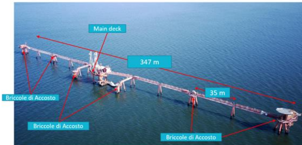
Figura 4.2 - Stato attuale del Pontile Offshore Petra (Pontile PIR) esistente.
